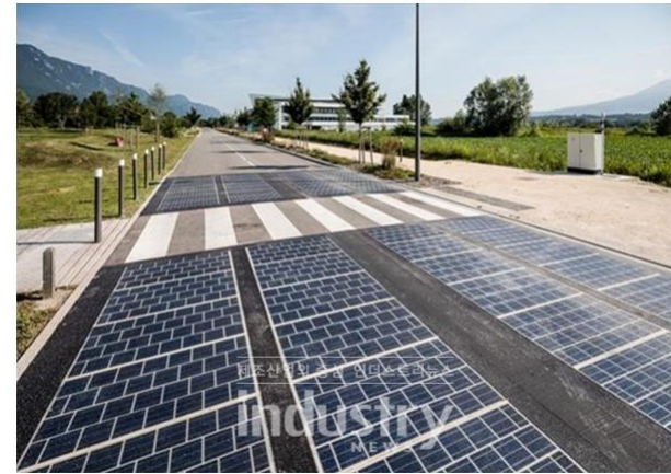
프랑스 Edouard Lucas 대학에 설치된 태양광 도로 [사진=슬리플렉스]
